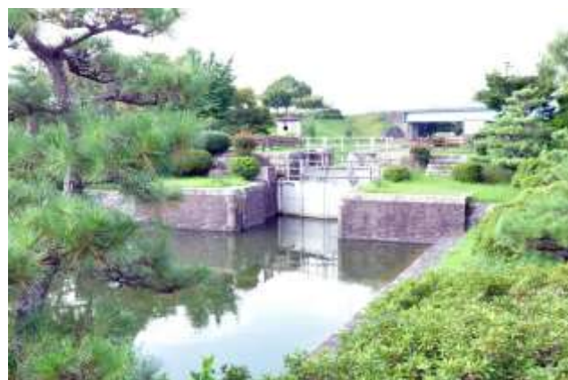
視察 船頭平閘門
